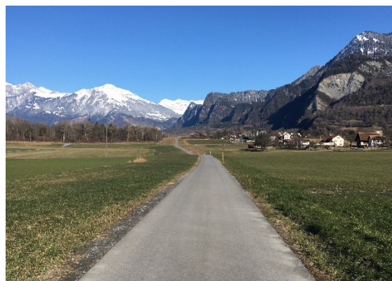
Auf dem alten Trasse der Nordspur neu erstellte Güterstrasse, Blick Richtung Norden
